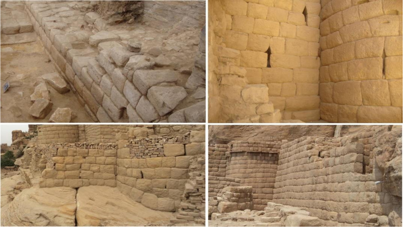
صورة رقم 3: توضح نوع وشكل أحجار البناء وأسلوب انتظام الصفوف واستقامتها وتلاحم الأحجار والصفوف دون استخدام أي من المواد الرابطة.
